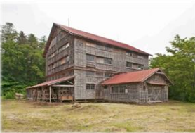
四階倉庫 ※重要文化財に指定された21棟から
